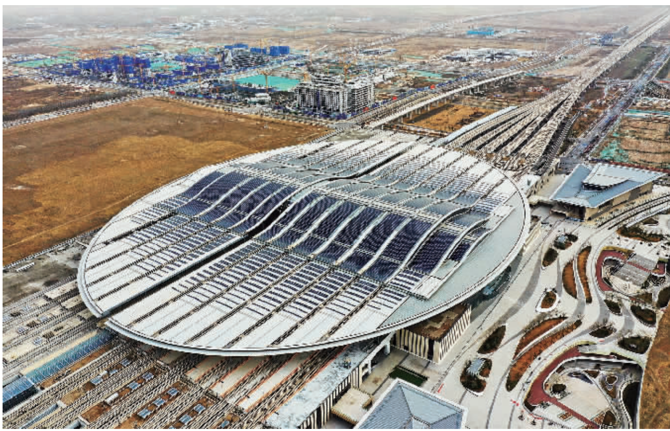
这是京雄城际铁路雄安新区站(2023年3月23日摄,无人机照片)。
