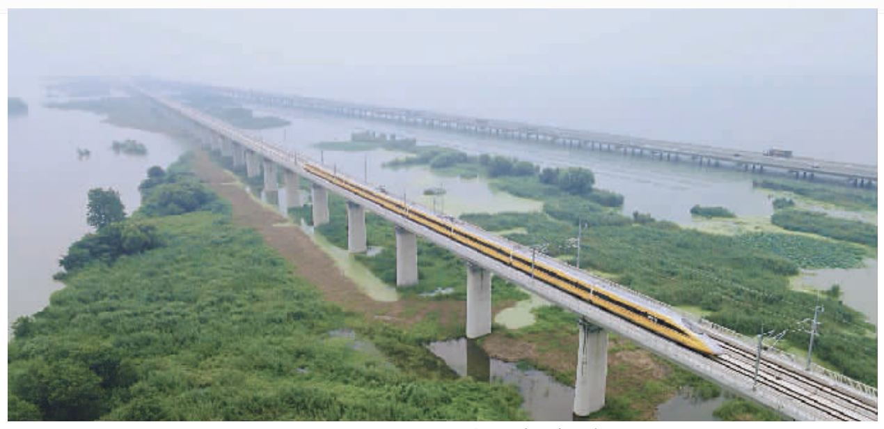
试验列车驶过沪宁沿江高铁常州特大桥湖段。 通讯员 陈丹驰 摄
